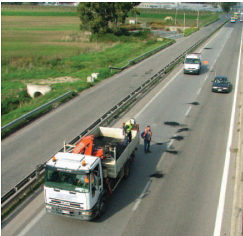
RATTOPI IN CORSO Intervento sulle buche della Pontina
