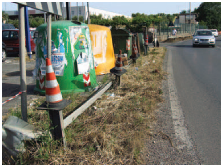
NETTUNENSE Coni al posto del guard rail in curva e strisce sbiadite
