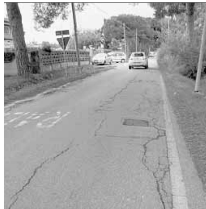
Ro.Ce. Un tratto di via Albanese a borgo Piave
