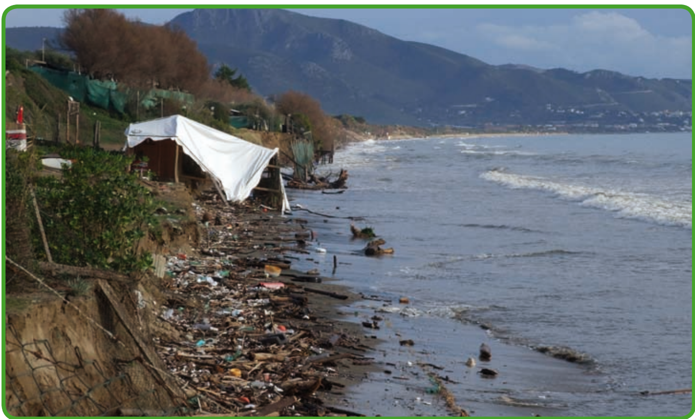
Danni dell'erosione sul litorale pontino
