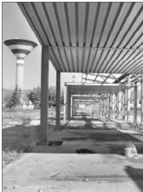
Il cantiere in via dell'Alloro
