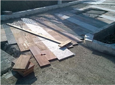
LAVORI CONTESTATI Posa della pavimentazione in marmo multicolore
