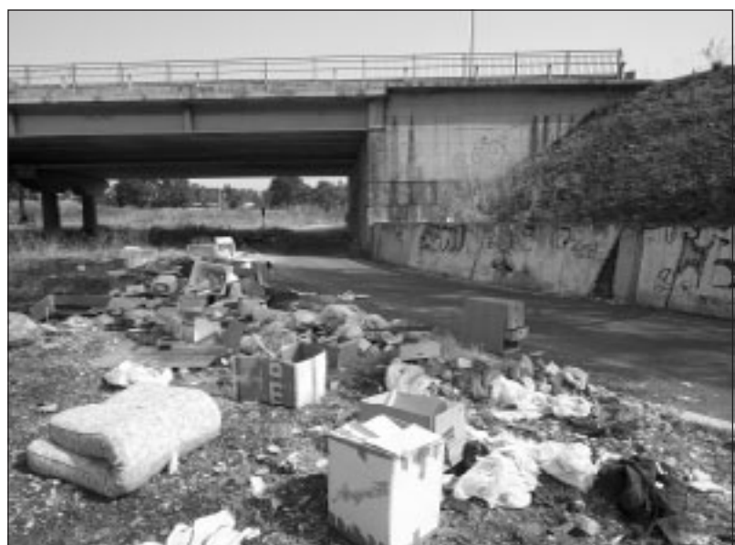
Un'immagine che mostra il degrado sotto il ponte di via Vespucci
