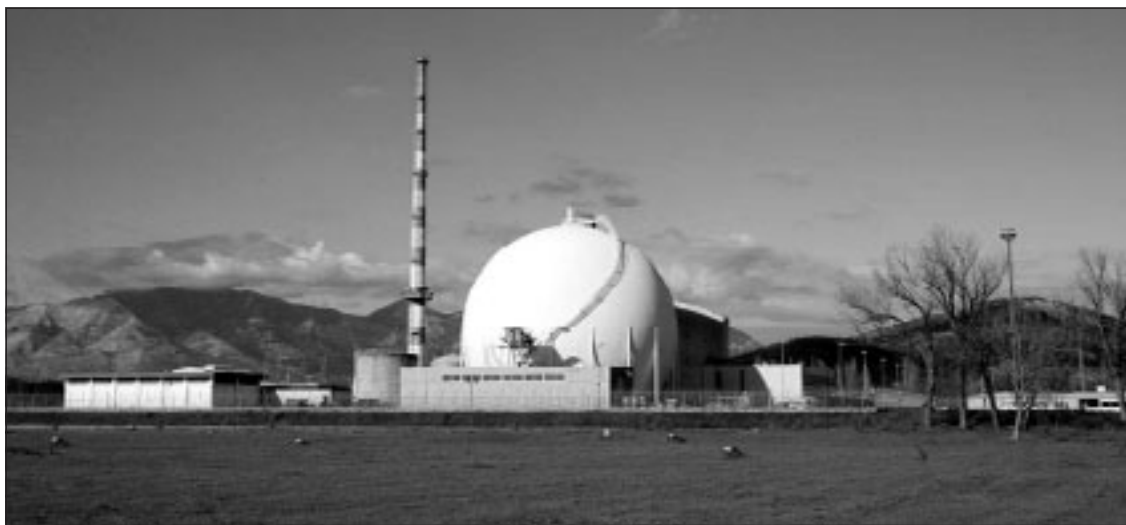
Nelle foto la piana del Garigliano dove dovrebbe sorgere la discarica
